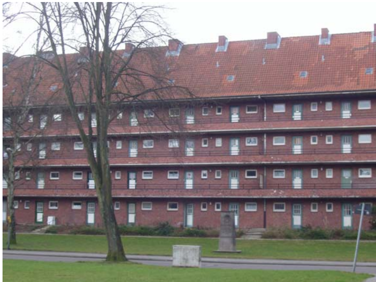
Foto 8: Laubenganghaus im Stein- kamp bietet Möglichkeiten für den seniorengerechten Umbau (Eigentümer: Kock- Siedlung)
