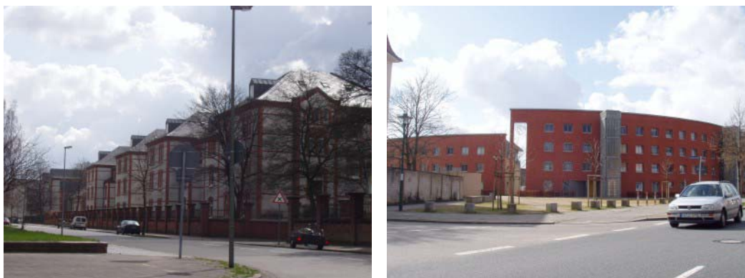
Fotos 21 und 22: Ehemaliges Kasernengelände mit Altbauten und Neubau
