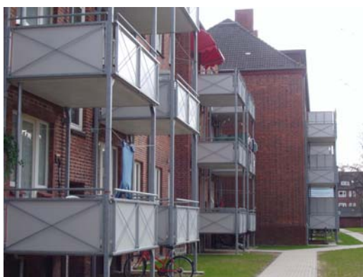
Foto 5: Balkonanbauten im Stadtteil West (Hansaring)
